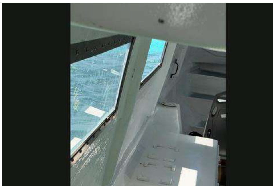
Figura 3. Vista interior de la cabina evidenciando ausencia de los paneles de vidrio laterales tras su desprendimiento.
