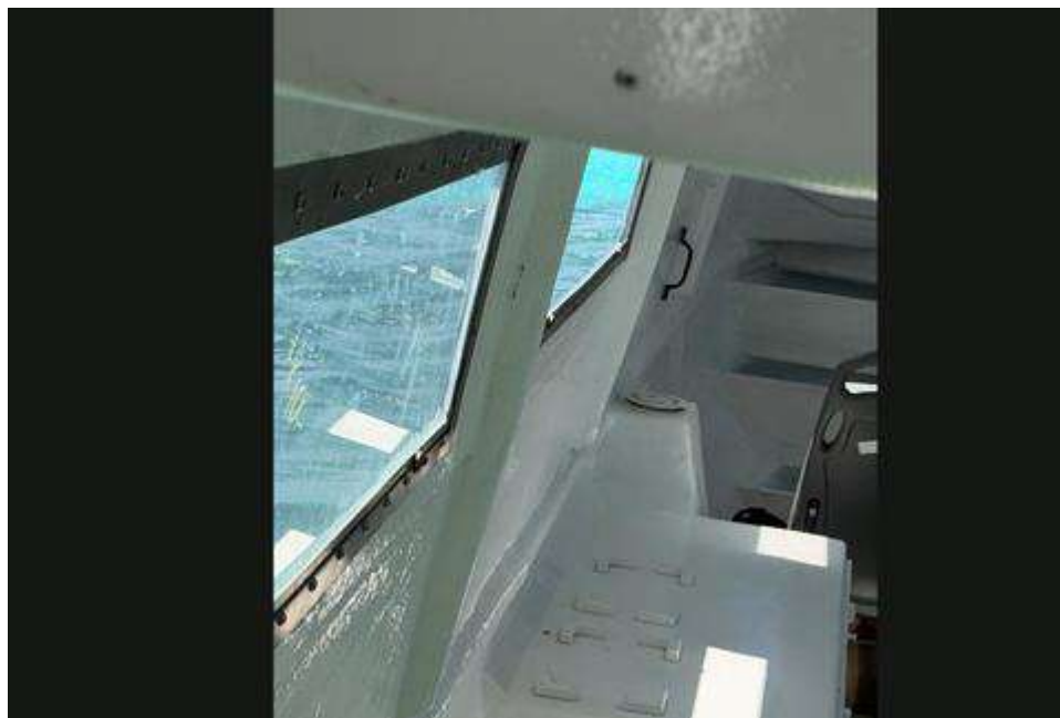
Figura 4. Vista interior de la cabina evidenciando la ausencia de los vidrios laterales tras el desprendimiento.
