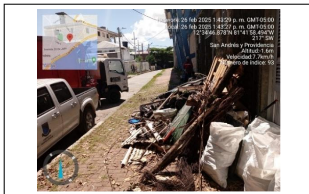
Limpieza de residuos especiales
