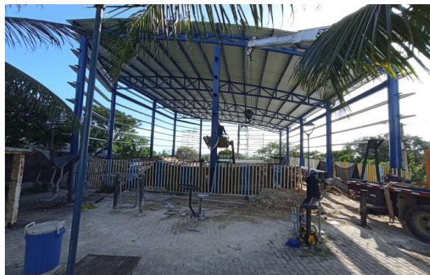
Foto 11. Mantenimiento y Mejoramiento Cancha Barrack
