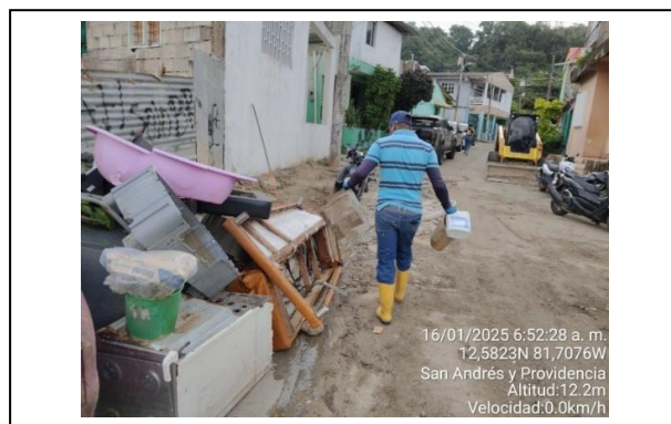
Limpieza de puntos críticos
