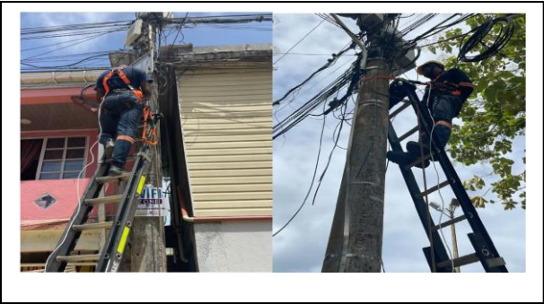
Instalación de equipos zona wifi Natania
