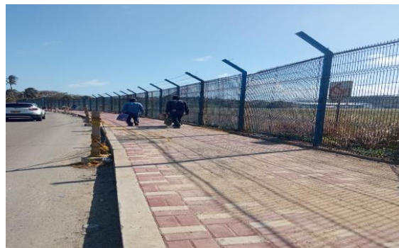
Foto 8. Mantenimiento y Construcción Andenes
