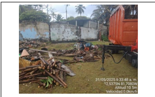
Limpieza de residuos especiales
