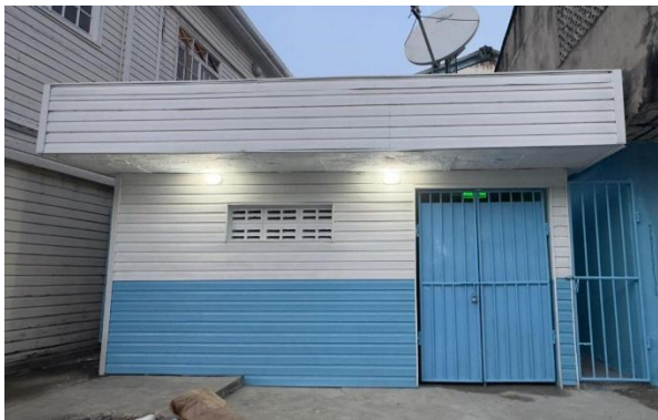
Foto 24. Mantenimiento Estaciones de Bombeo de Aguas Lluvias
