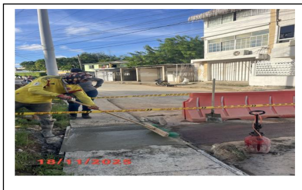
Reposición de espacio público Calle 4 interno sector Sarie Bay
