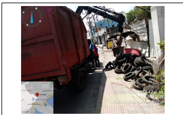
Limpieza de puntos críticos
