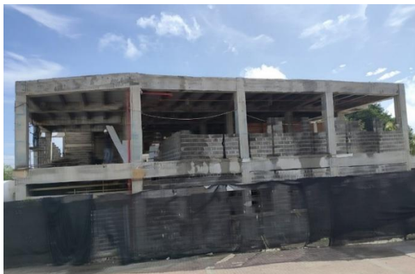
Foto 10. Construcción Edificio Administrativo Hospital Clarence Newball
