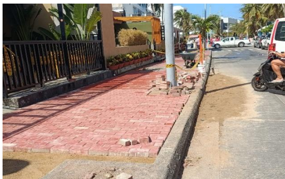
Foto 7. Mantenimiento Andenes Av. Newball
