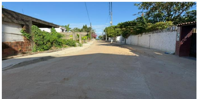
Foto 23. Fase I – Acueducto de Morrislanding
