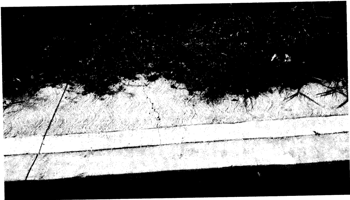
Ilustración 8 K1+ 328 anden con fisura
