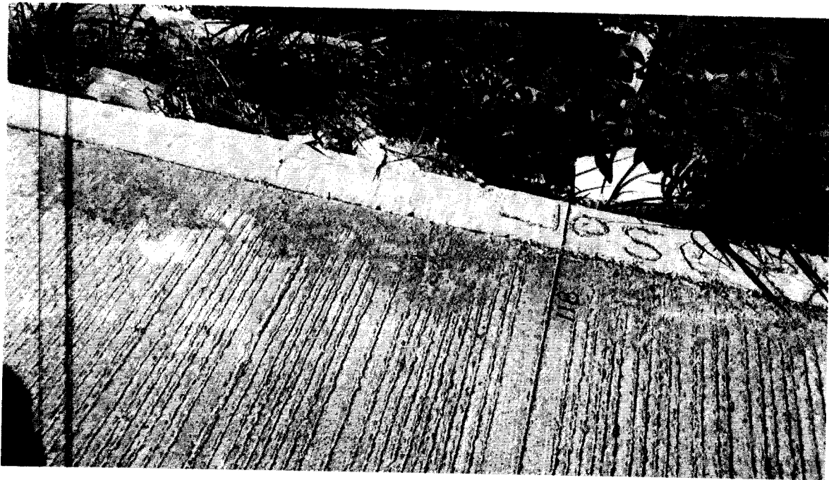
Ilustración 9 K1+669,2 superficie capa de pavimento
